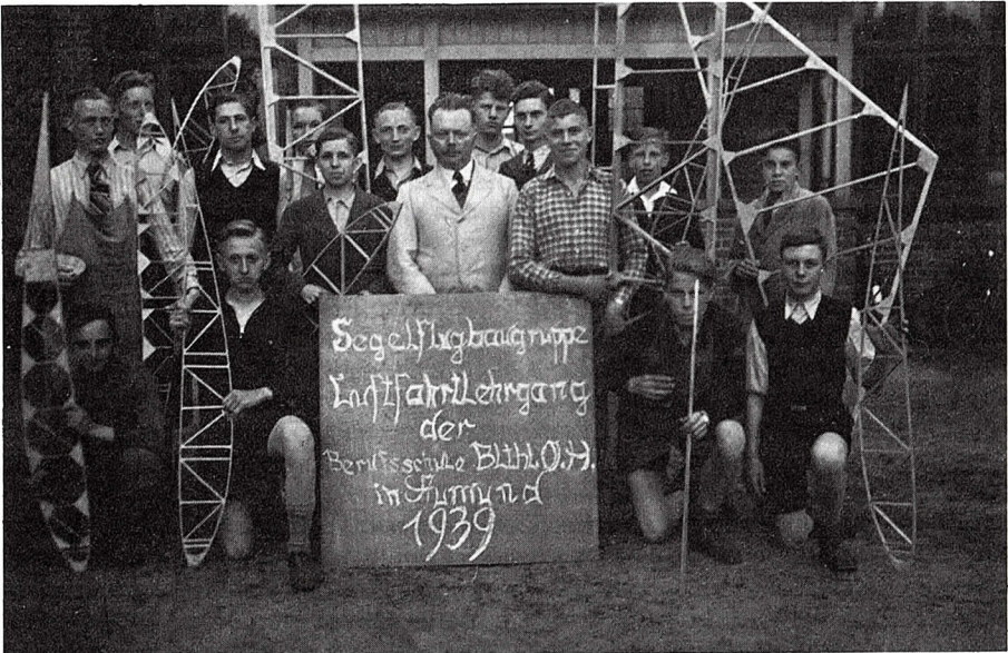
1939 – Die Garlstedter Segelfluggruppe mit Bauleiter Günther (Spitzname: Spannack). Die Bauteile sind für den Zögling 35 (Spannweite 12 m) bestimmt.
